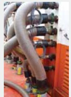
Les flexibles Isopad sont également employés pour chauffer des huiles légères dans des zones soumises à des conditions hivernales difficiles, les températures basses augmentant la viscosité des huiles légères et la rendant ainsi difficile à pomper si elles ne sont pas chauffées.
